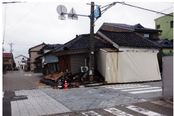
石川県七尾市の被害状況
